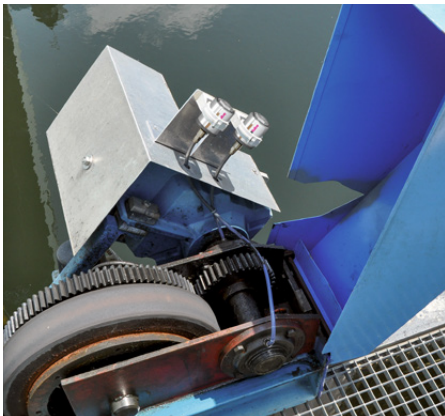
Smörjning av lager via slang i eftersedimenteringsbassäng.
