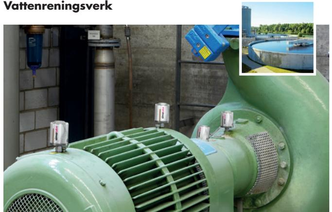
60 ml lubrikatorer på en elmotor och drivaxel smörjer kontinuerligt en centrifugalpump.
